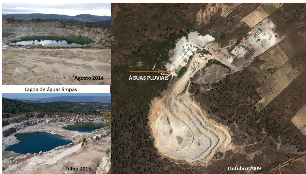
Figura 2 – Acumulações de águas na Pedreira
