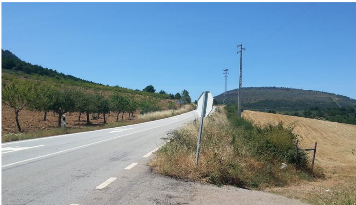
Figura 16 – Local previsto para a passagem inferior a construir
