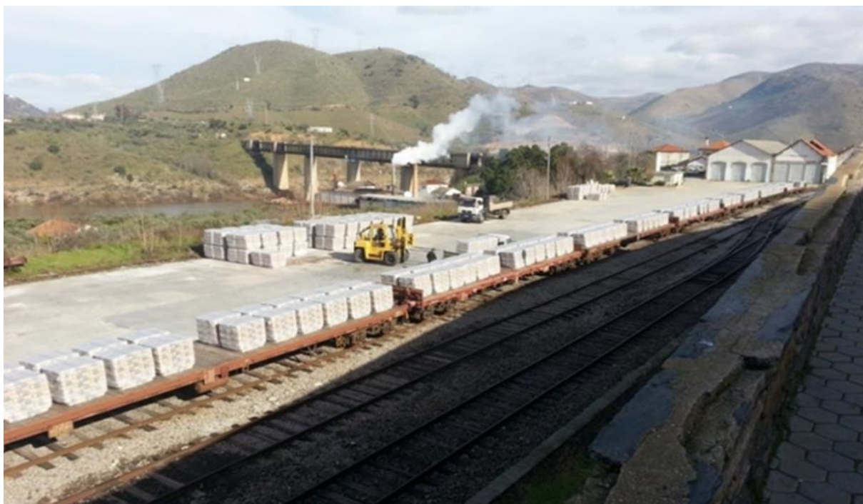
Figura 33 – Plataforma de mercadorias do cais ferroviário do Pocinho durante a descarga de paletes de cimento
